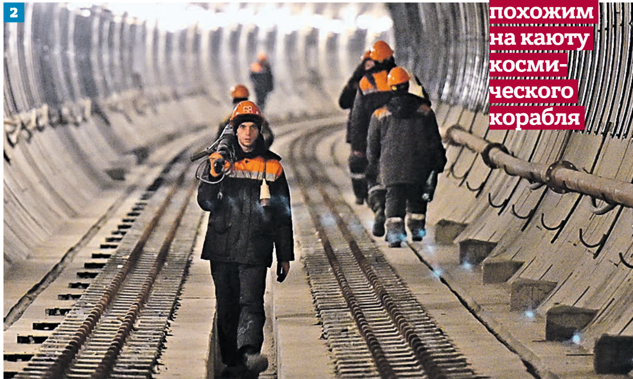
Дизайн-проект станции «Воронцовская» Большой кольцевой линии Московского метрополитена (1) Строители в тоннеле к станции «Воронцовская» (2)
