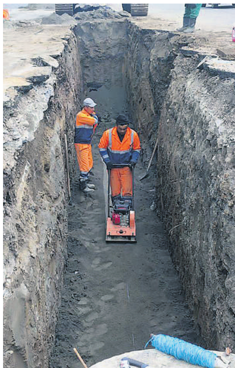
Одновременно идет и укладка инженерных сетей.
